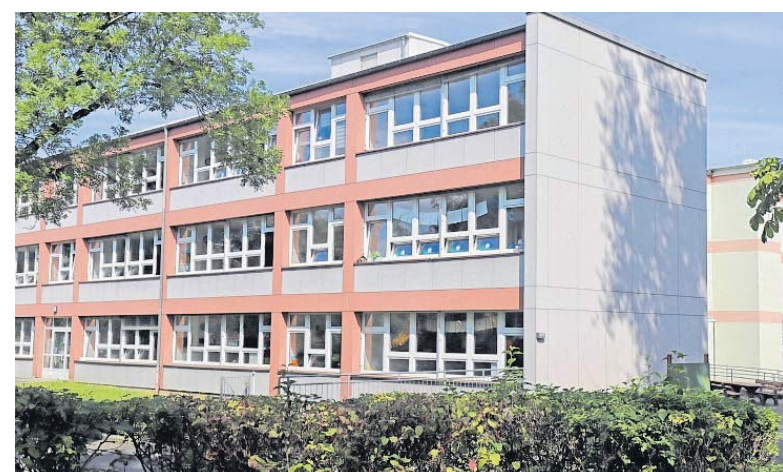
Um mehr Platz zu gewinnen, sollen zwei Wohncontainer auf das Gelände der Clemens-Winkler-Schule in Freiberg gestellt werden.
